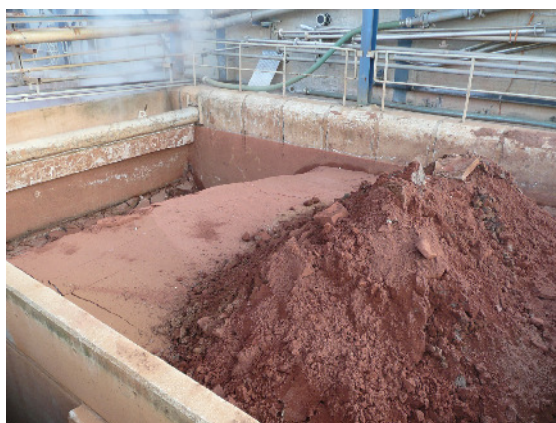
Aschebecken als Zwischenspeicher und zum Auswaschen von gut löslichen Salzen wie z.B. Kochsalz, Natriumsulfat.
